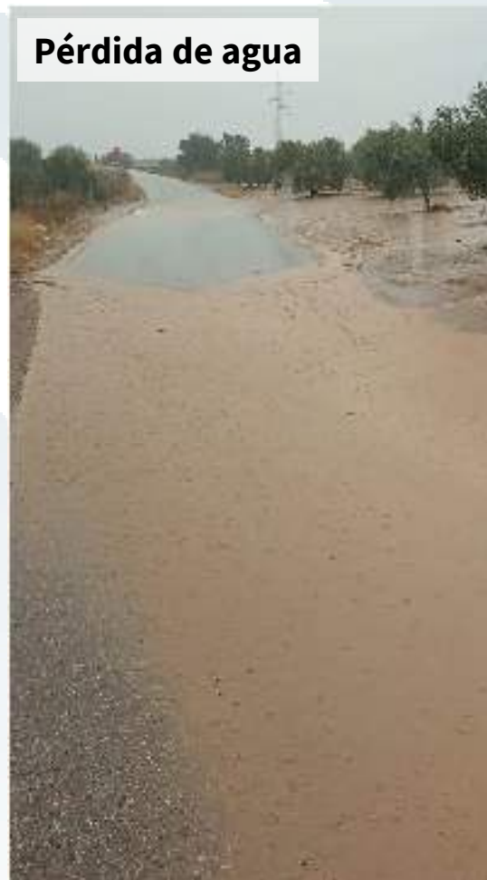
Pérdida de agua en riego de goteo
